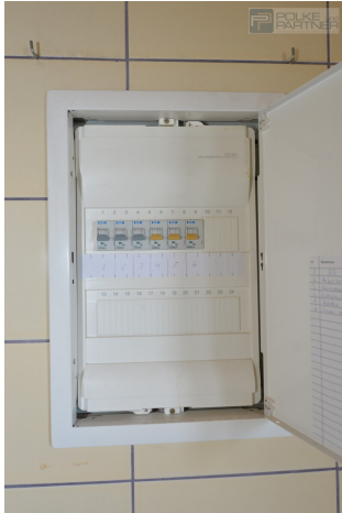
Sicherungskasten
