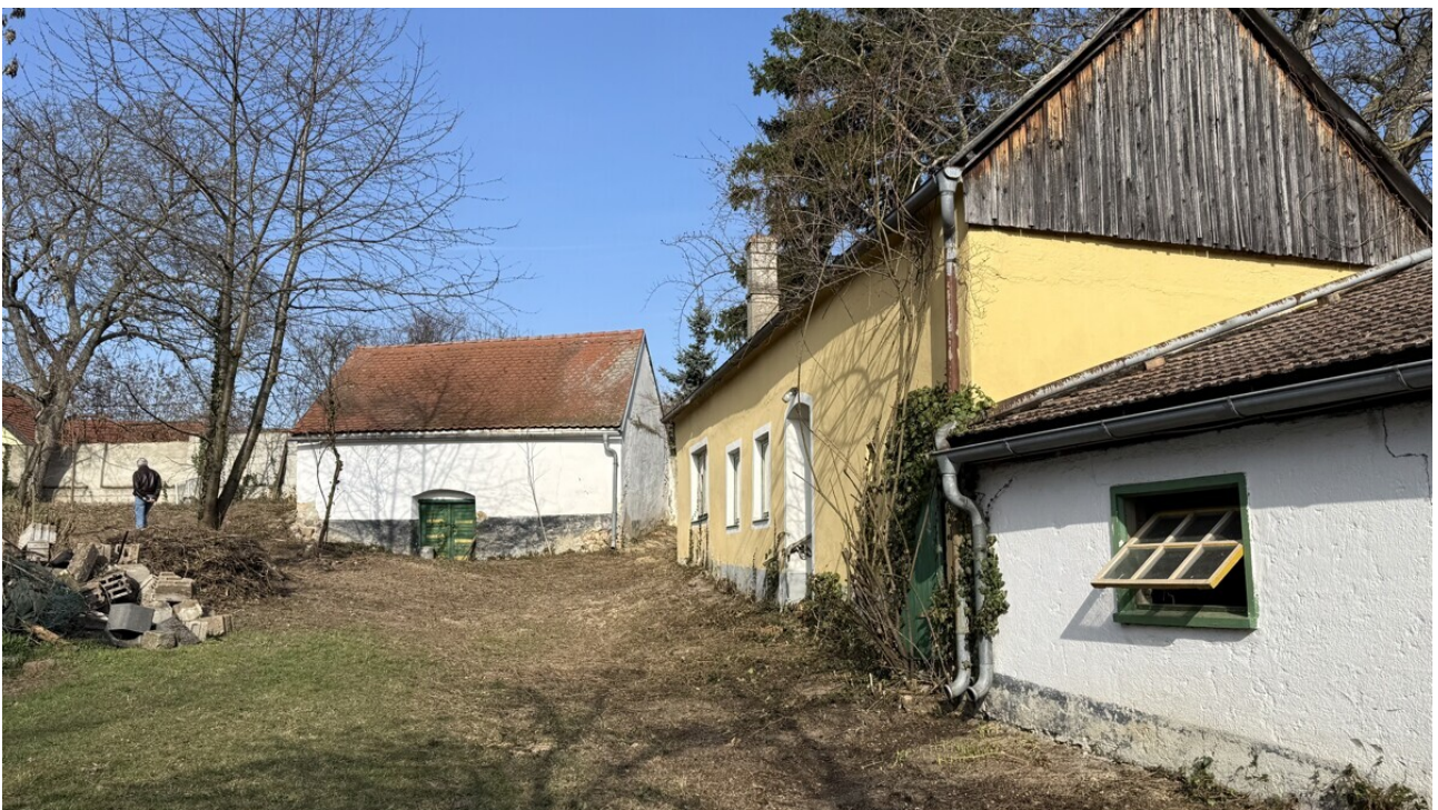
Presshaus Wohnhaus Nr.2 und Schuppen Nr. 10
